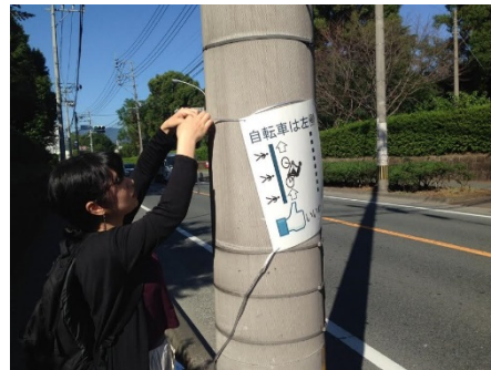
写真4：標識の設置状況
